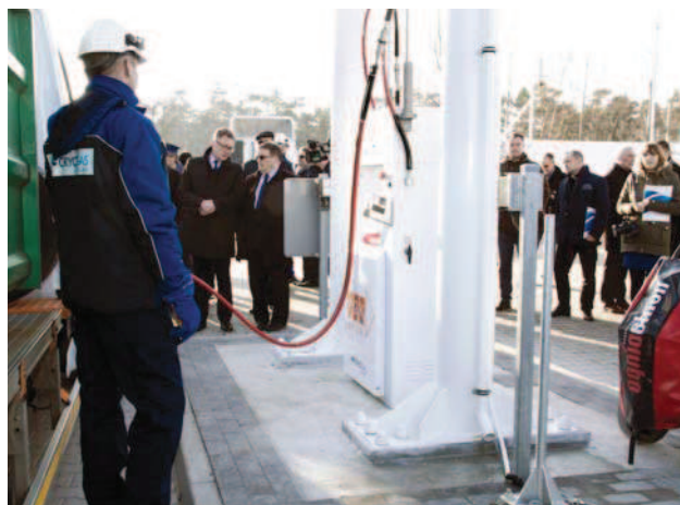
W Mateuszewie zainstalowano jednostanowiskowy dystrybutor tankowania LNG oraz dwustanowiskowy dystrybutor tankowania CNG. Auto użytkowe można zatankować w ciągu kilku minut.
